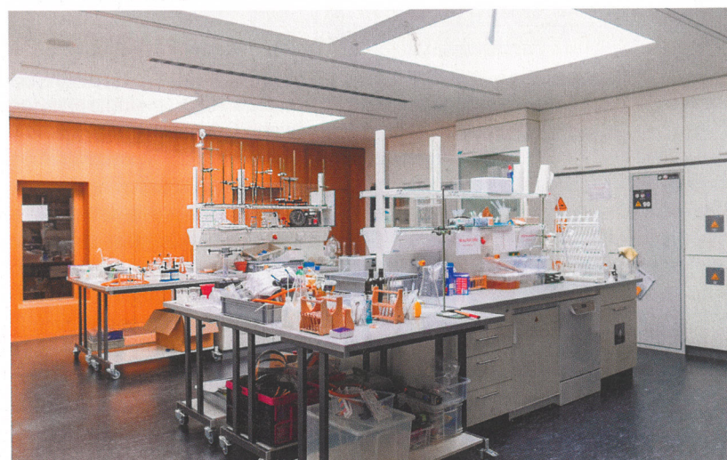
In den Laboren wird die Abluft aus den Chemikalienschränken kontinuierlich abgesaugt, damit sich keinerlei Gefahrstoffe ansammeln können.
