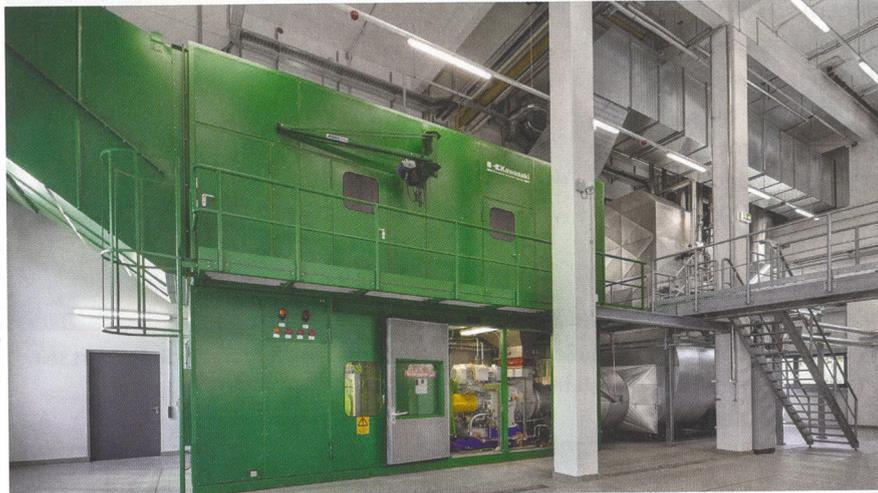
Eine hocheffektive Gasturbine, die auch mit Bio-Erdgas betrieben werden kann und H<sub>2</sub>-ready ist, versorgt die Produktion mit Dampf, Wärme und Strom
