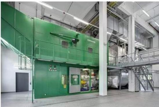
*Eine hocheffektive Gasturbine die auch mit Bio-Erdgas betrieben werden kann und H<sub>2</sub>-ready, also für Grünen Wasserstoff vorbereitet ist - versorgt die Produktion mit Dampf, Wärme und Strom. Quelle: Gammel Engineering GmbH*
