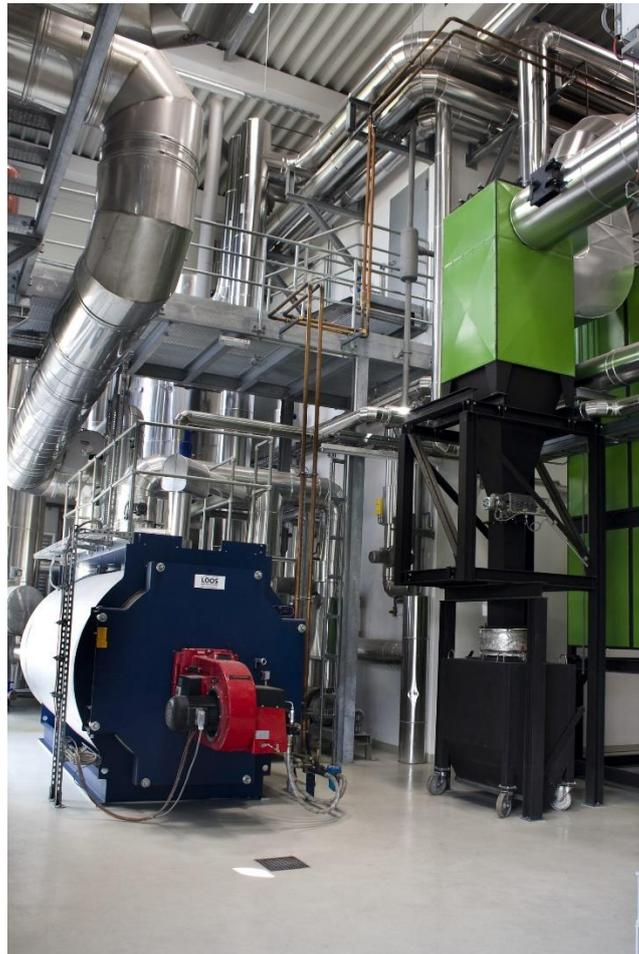
*Durch die kontrollierte Verbrennung entsteht Prozesswärme als Dampf, der über ein Leitungssystem zu den verschiedenen Prozessstationen auf dem Brauergelände geführt wird.*
