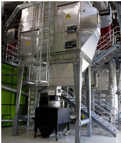
**Durch die kontrollierte Verbrennung** entsteht Prozesswärme als Dampf, der über ein Leitungssystem zu den verschiedenen Prozessstationen auf dem Brauergelände geführt wird.
