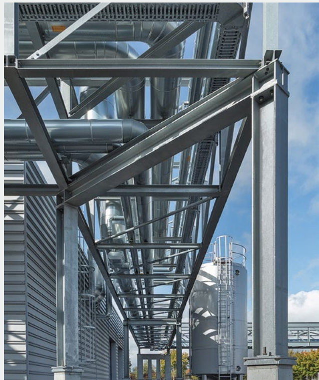
Fig. 4 Weil die alte Leitungsführung der notwendigen Erweiterung eines Hochregallagers und der dazugehörigen Förderbrücken im Weg stand, legte Gammel Engineering eine optimierte Medientrasse zwischen Käserei und Kraftwerk.
