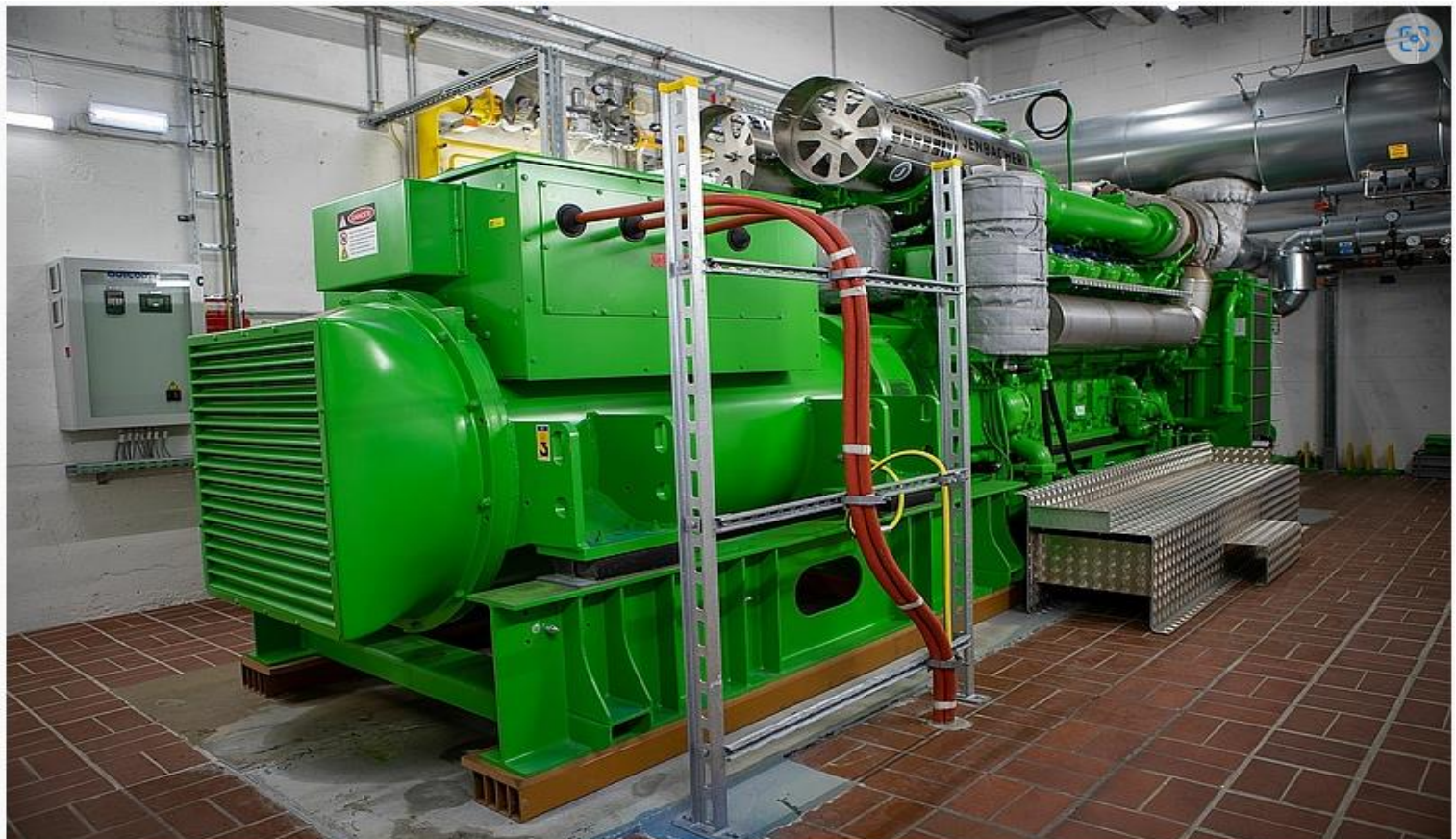
Durch das erdgasversorgte BHKW mit einer Wärmeleistung von 2.000 kW kann ein erheblicher Teil der Stromversorgung gewährleistet werden, wobei eine ergänzende Versorgung „von außen“ erfolgt.
