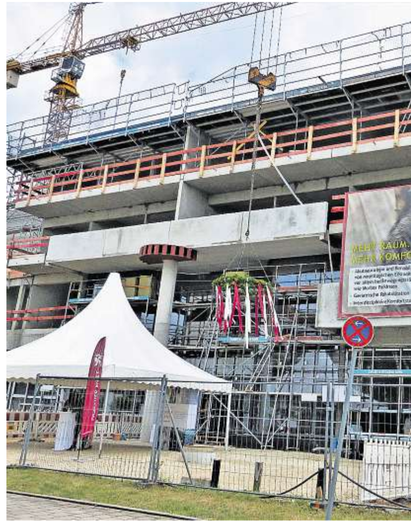
Mit Beifall wurde der Richtkranz in die Höhe gezogen.
