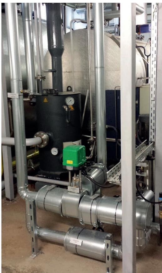
Die Neuinstallation erforderte neben dem Austausch mehrerer Komponenten wie des Kessels auch die Verlegung neuer Rohrleitungen, die für die Beförderung des Erdgases ausgelegt sind. Zudem wurden mehrere Wärmetauscher und Economizer angeschlossen, welche die Wärme des Rauchgases optimal ausnutzen.
