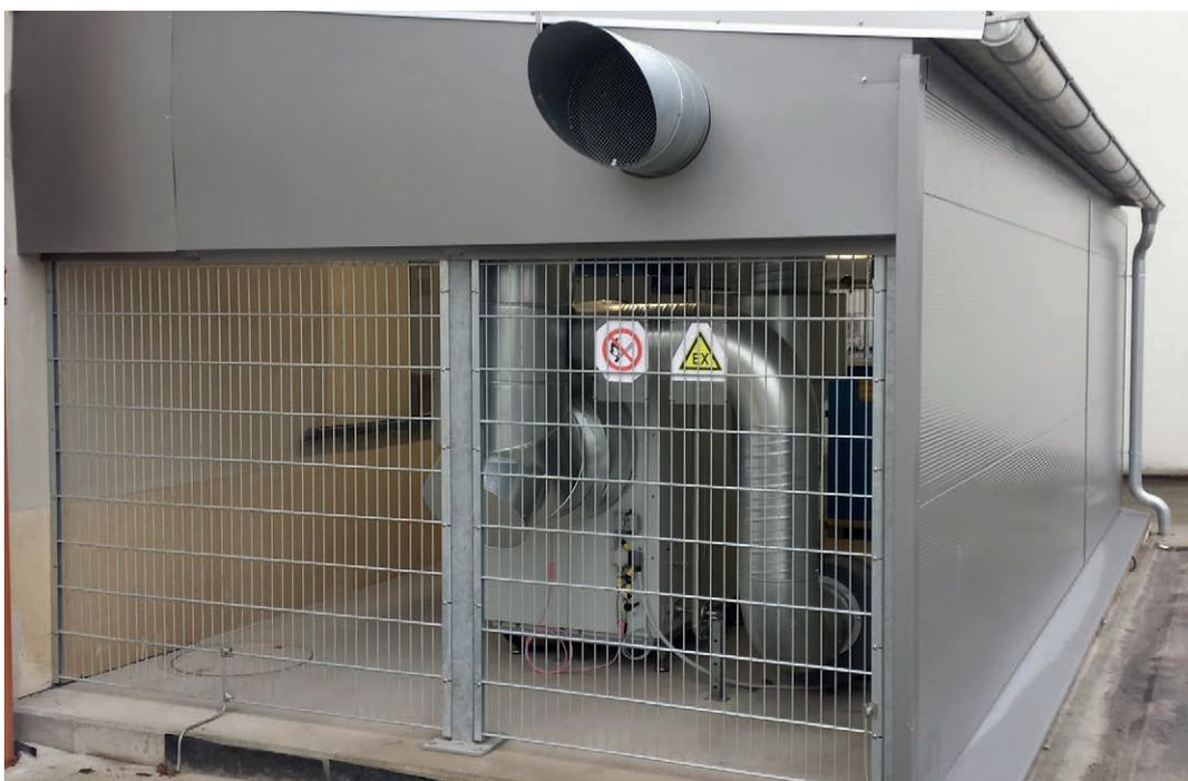
Die neue Turbine erzeugt neben 100 kW Strom auch Abgase. Diese durchströmen einen speziellen Vierzugkessel und produzieren so 0,5 t/h Satttdampf, der die Grundlast im Betrieb abdeckt. Bei einem höheren Bedarf kann zusätzlich ein stufenloser Gasbrenner betrieben werden, sodass im Kombibetrieb bis zu 2,5 t/h Satttdampf erzeugt werden.
