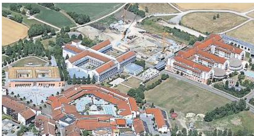
In Bad Gögging entsteht (oben im Bild) die Fachklinik.
