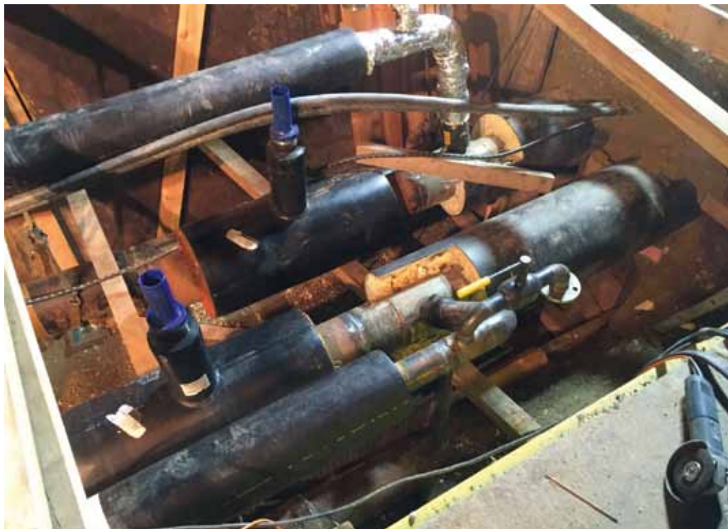
Das Ingenieurbüro Gammel Engineering wurde 2013 mit der Planung des Rohr- und Tiefbaus für das Fernwärmenetz der Stadt Landshut beauftragt, das sich aus einem umgerüsteten Biomasseheizkraftwerk speist. Die verlegten Leitungen inklusive Haupttrasse und Abzweigungen erreichen mittlerweile eine Länge von 26 Kilometer.
