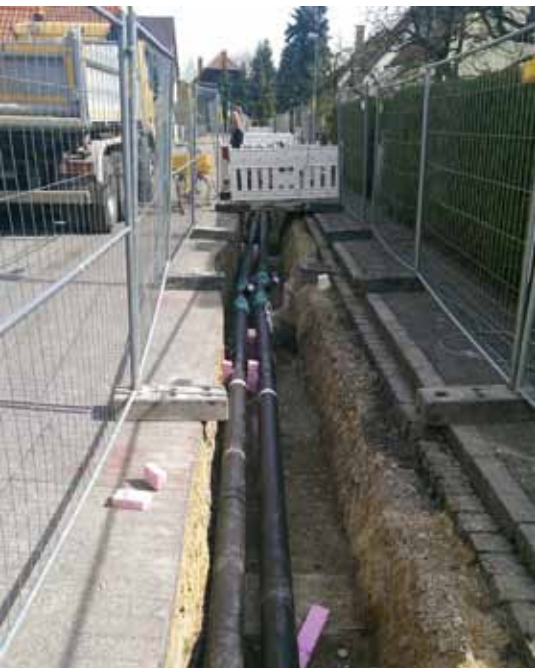
Das CO 2 -neutrale Fernwärmenetz versorgt rein rechnerisch 4000 Haushalte mit Wärme aus nachwachsenden Rohstoffen. Leitungen führen unter anderem zur Siedlung Schönbrunn.
