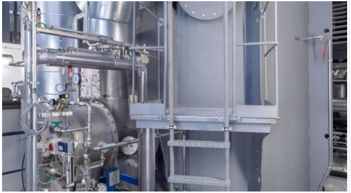
Das Kombi Power System, das ReGaWatt für Romande Energie installieren wird, kommt auf eine Feuerungsleistung von 4,200 MW. (Foto: Gammel Engineering)
