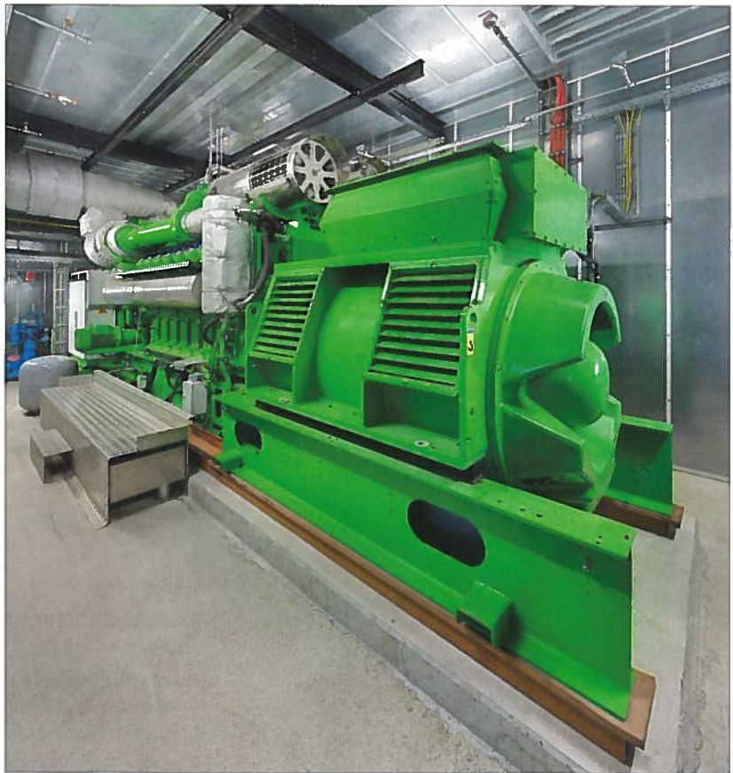
Bild 3. Ein zusätzliches Blockheizkraftwerk mit einer Leistung von 2,4 MW(th) und 2,6 MW(el) komplettiert das Energiekonzept
