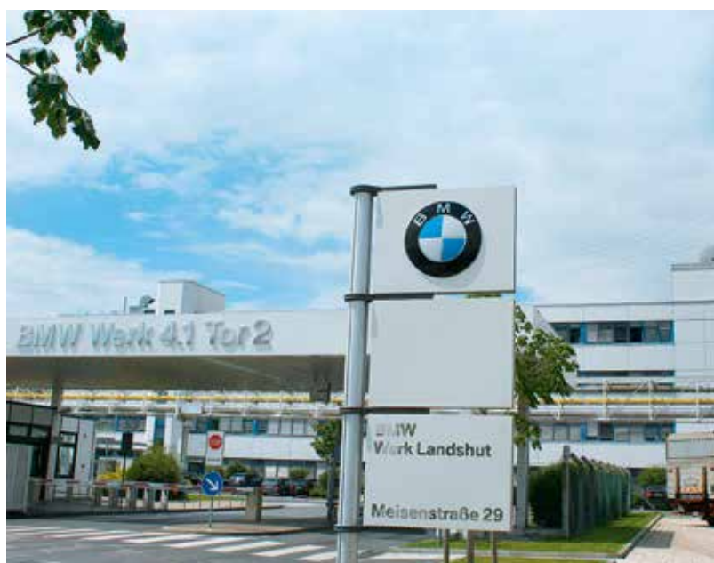
BMW-Werk in Landshut: Der Plan, Primärenergie und Emissionen mit einem neuen Konzept zu reduzieren, ist aufgegangen.
