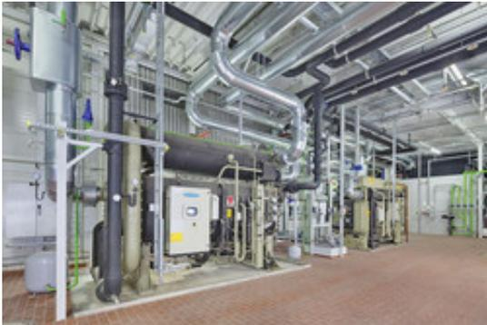
In der Energiezentrale des BMW Group Werks Landshut wurden zwei Absorptionskältemaschinen errichtet, die die Abwärme aus den Schmelzöfen nutzen, um Kälte zu erzeugen.
