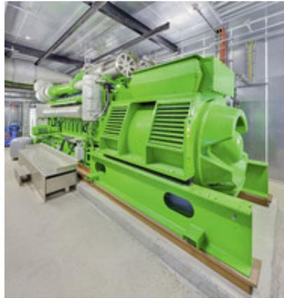
Ein zusätzliches Blockheizkraftwerk mit einer Leistung von 2,4 MW<sub>th</sub> und 2,6 MW<sub>el</sub> komplettiert das neue Energiekonzept, sodass durch die neuen Anlagen die Grundlast praktisch vollständig abgedeckt werden kann.
