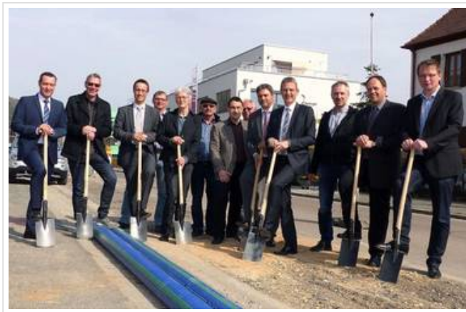
Armin Kroder, Harald Kiesel, Robert Ilg, Peter Uschalt, Stadträte, Vertreter von Naturenergie, Hewa und der Baufirmen begannen mit dem Spatenstich den Bau der Hersbrucker Fernwärmeleitung in der Amberger Straße.
