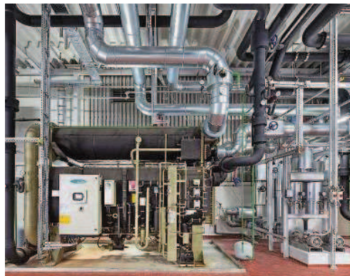
Blick in die BMW-Energiezentrale: Links sieht man die Absorptionskältemaschine 1, rechts Heißwasserpumpen; in den silberfarbenen Rohren fließt Heißwasser, in den schwarzen Rohren Kaltwasser. Fotos: Spahn
