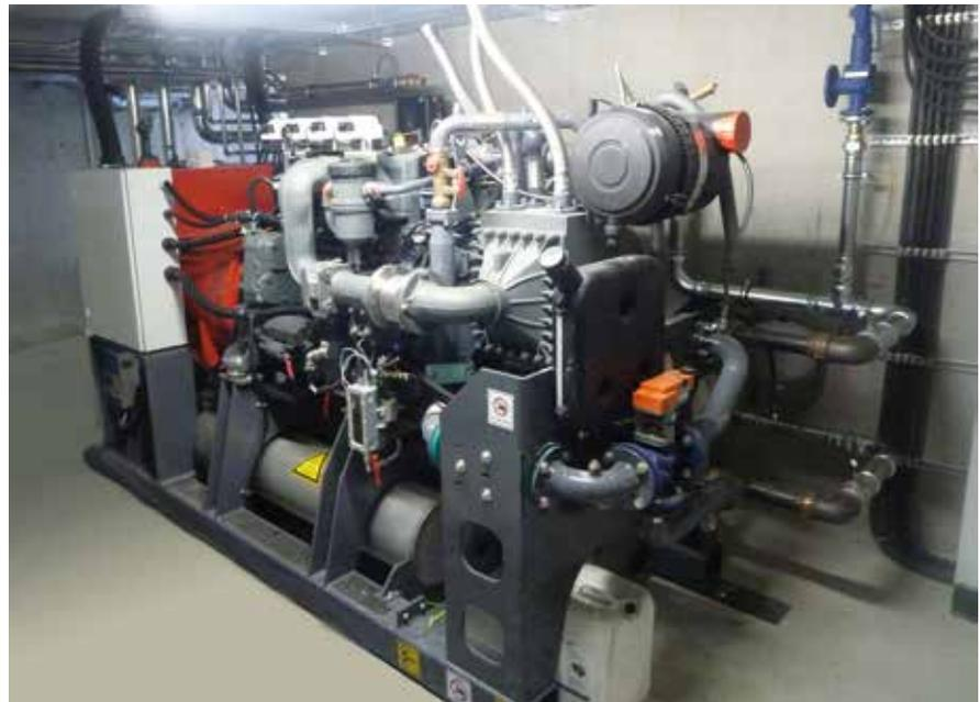
Blockheizkraftwerk mit Wärmeleistung von 155 kW und 130 kW an Stromerzeugung.
