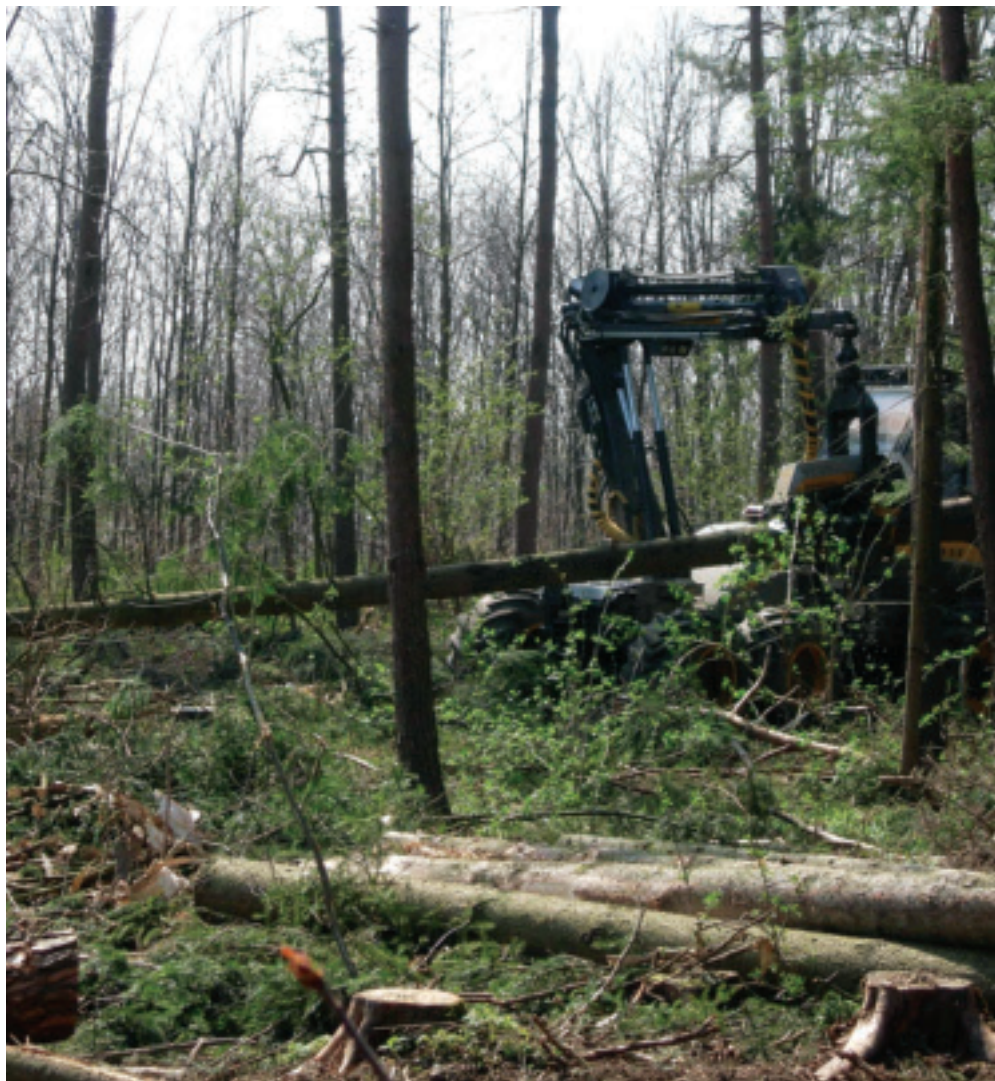
April 2007: Die Rodung für das Kraftwerk beginnt
