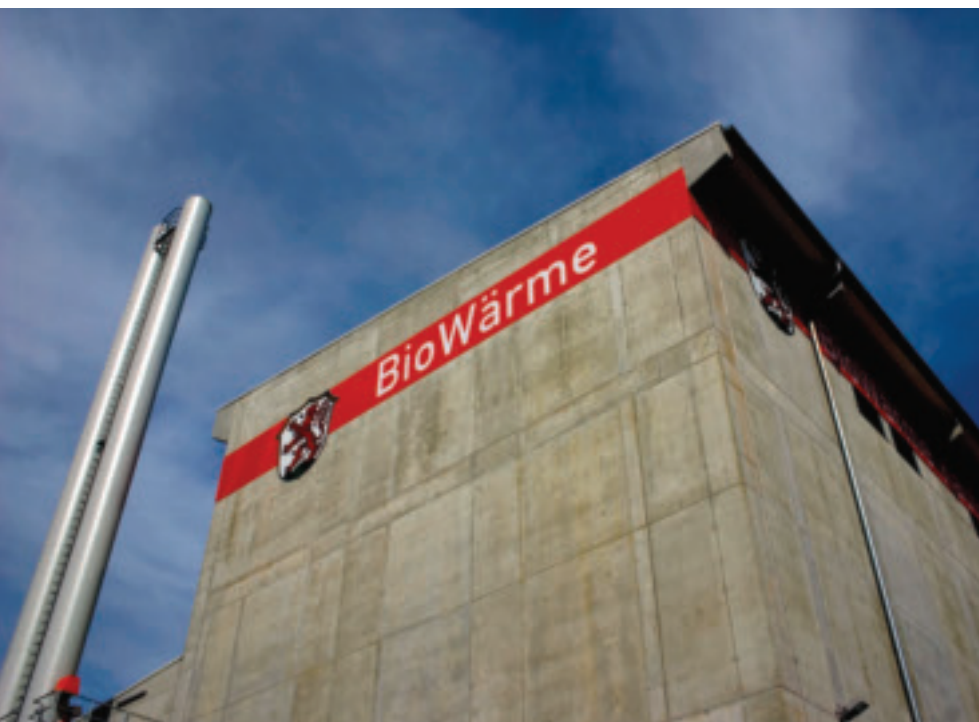
Industriebau Heizkraftwerk - Funktionalität und Wirtschaftlichkeit im Vordergrund
