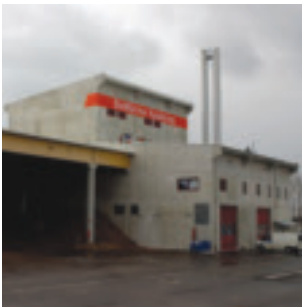
Außenansicht des neuen Biomasseheizkraftwerks mit der Adresse Am Heizwerk 1
