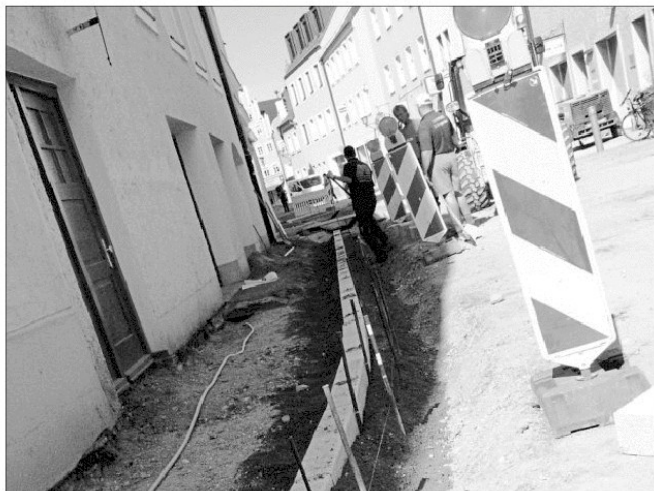
Die Abschnitte mit Kies und Sand werden weniger: Die Stadtwerke haben gestern den letzten Hausanschluss gelegt, das Tiefbauamt hat nun damit begonnen, die Gehwege zu asphaltieren, sagten (von links) Stadtwerke-Projektleiter Hans-Georg Eder, Ingenieur Peter Wölfl von der Firma Ferstl und Tiefbauamtsleiter Gerhard Anger. (Fotos: sig)
