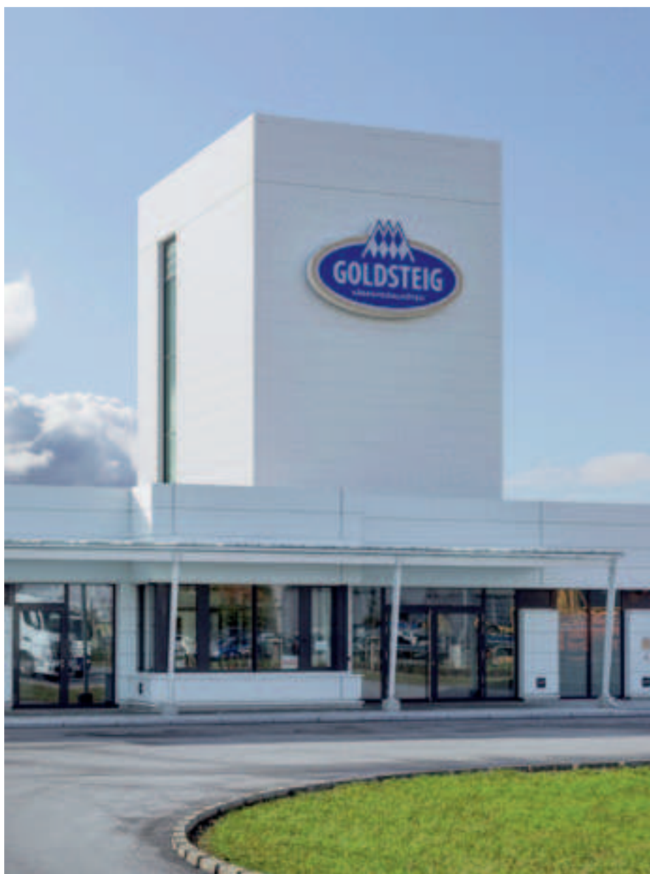
Die in der Oberpfalz ansässigen Goldsteig Käsereien haben 2017 mit dem Neubau eines zusätzlichen Standorts im niederbayerischen Stephansposching begonnen. Da der geplante Neubau über keine eigene Wärmeversorgung verfügen würde, musste eine Anbindung an benachbarte Energienetze erfolgen, die zudem modernen Anforderungen im Energiemanagement genügen sollte.
