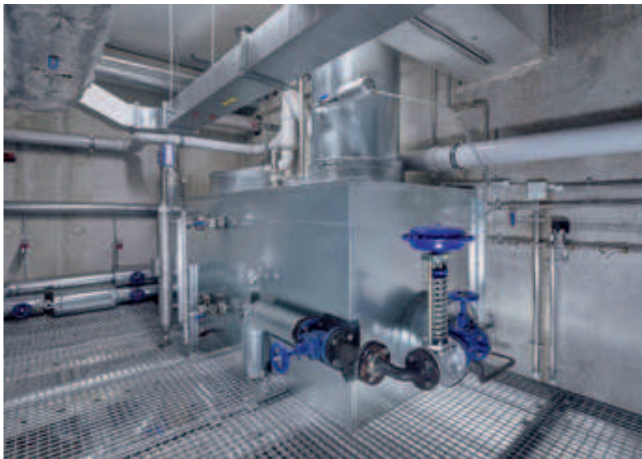
Ein Wärmetauscher mit einer besonders großen Tauscherfläche wurde installiert, um einen besseren Wärmeübergang ohne Druckverlust zu erzielen.
