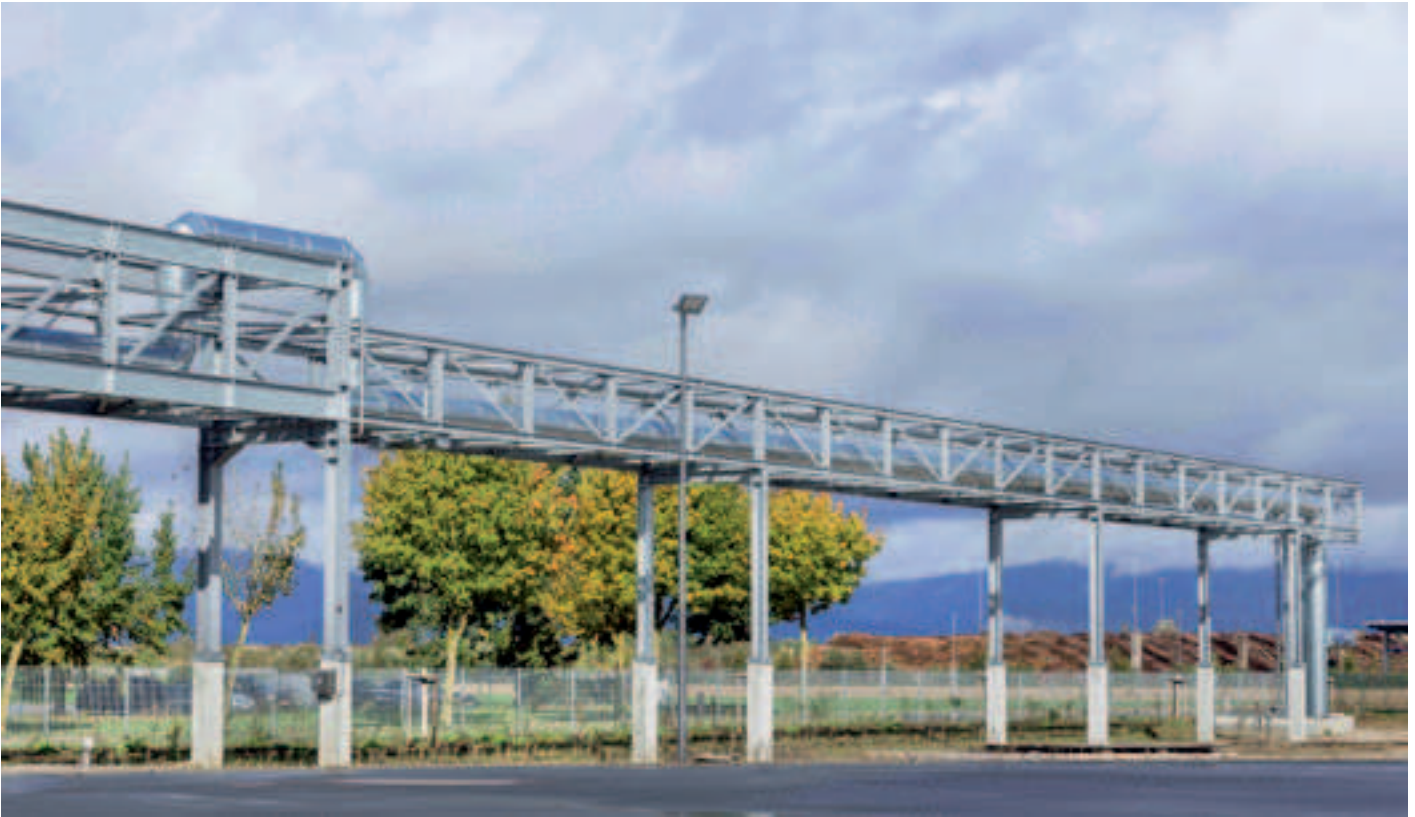
Über eine Rohrbrücke gelangt der Dampf über das Gelände der Molkerei zum Technikhaus.
