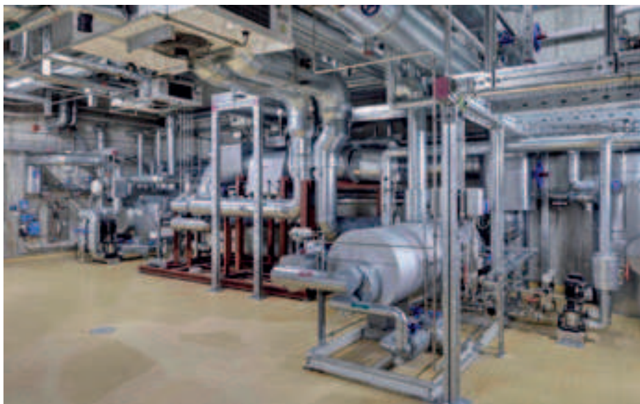
Ein Wärmetauscher mit einer besonders großen Tauscherfläche wurde installiert, um einen besseren Wärmeübergang ohne Druckverlust zu erzielen.
